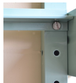
Schrauben sitzen unterhalb des T-Profiles
