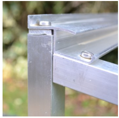
BEFESTIGUNG FIRSTPROFIL
