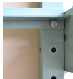
Schrauben sitzen unterhalb des T-Profiles
