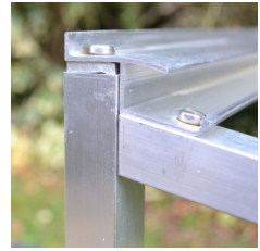
BEFESTIGUNG FIRSTPROFIL
